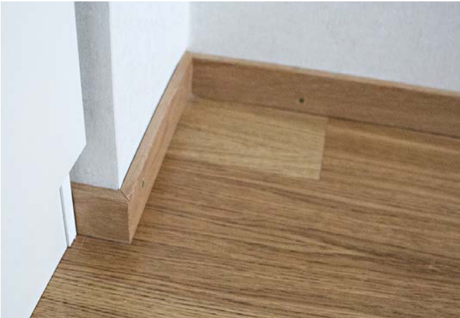
Väggar: målade eller tapetserade. Tak: målade.
